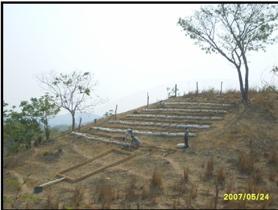
Figura 10-a. Construcción de las terrazas en la parcela demostrativa
